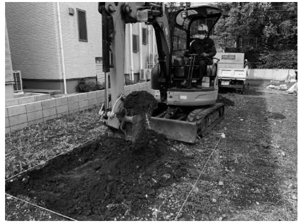
写真2 表土掘削 (東から)
