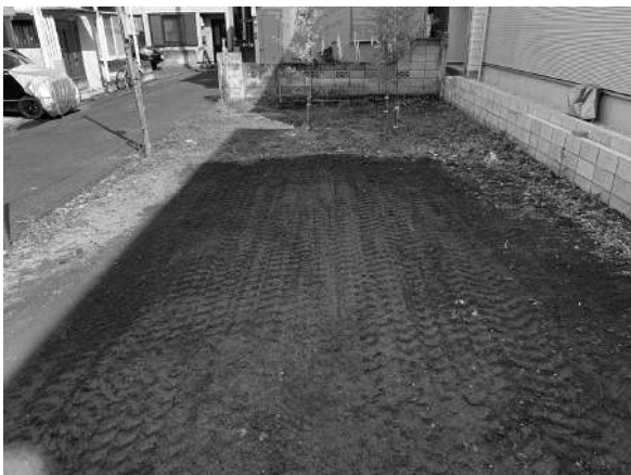
写真7 復旧状況 (西から)
