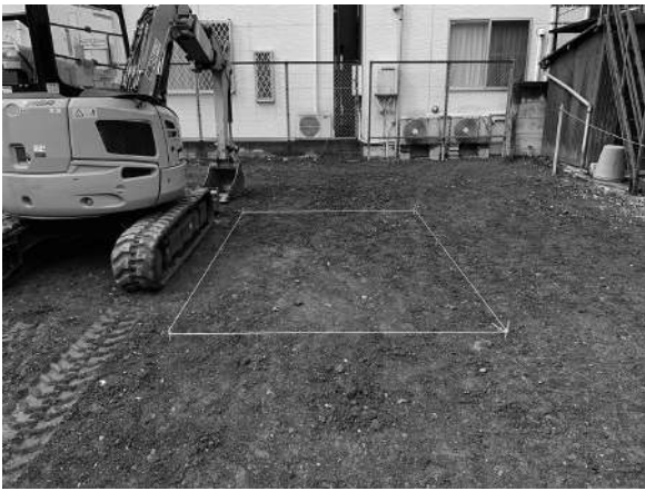
写真1 調査前状況（北から）
