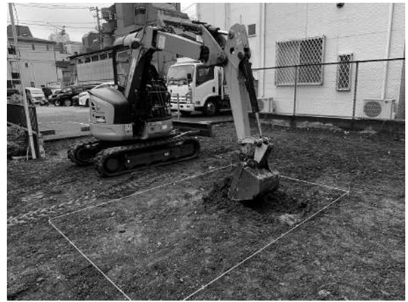
写真2 表土掘削状況（西から）
