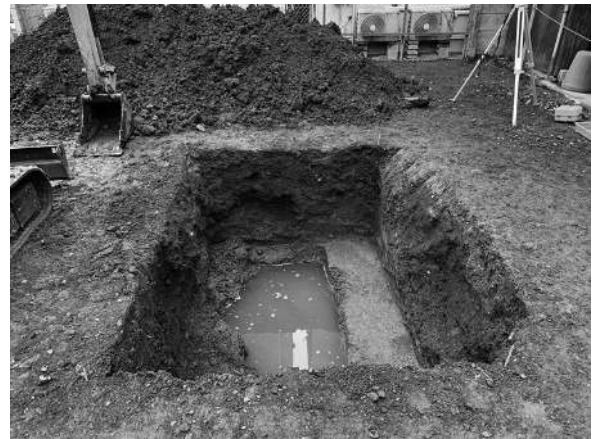
写真4 完掘状況（北から）
